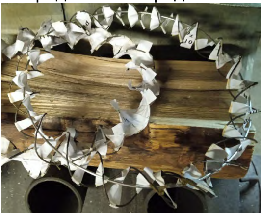
Рис. № 5. Установка внутреннего осевого кольца жёсткости.
